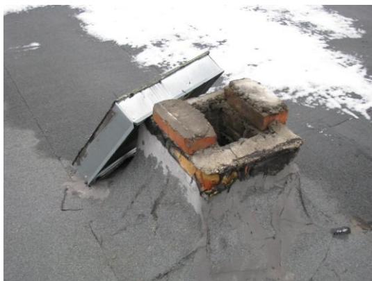
4.16.1. un 4.16.2.att. Ventilācijas šahtu un kanālu izvadi virs jumta.
